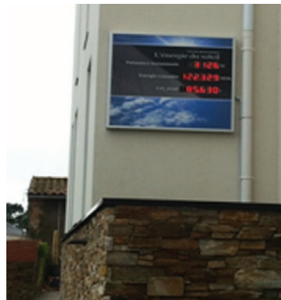
Compteur extérieur au Leroux Bottereau (44)
