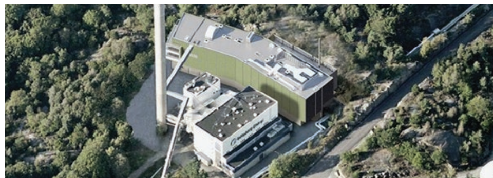
Figure 5 : Usine GoBiGas en Suède
