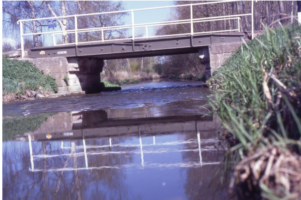
Le pont de la Blind, posé le 28 janvier 1945, tel qu'on pouvait le voir en 1991, avant son élargissement. PHOTOS DNA
