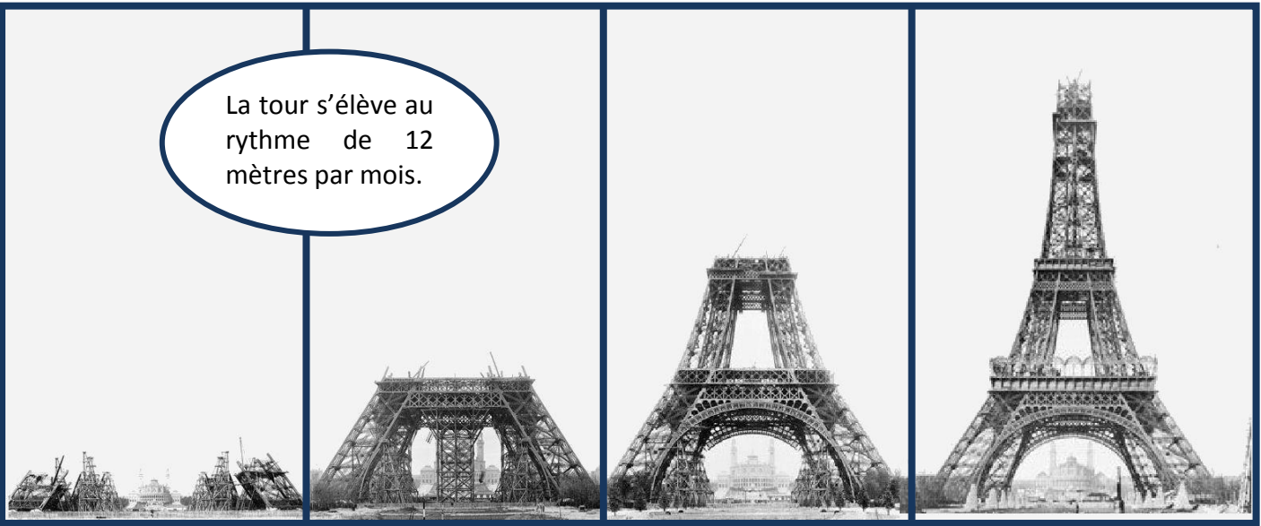
Des étapes de construction de la tour Eiffel (entre 1888 et 1889)
