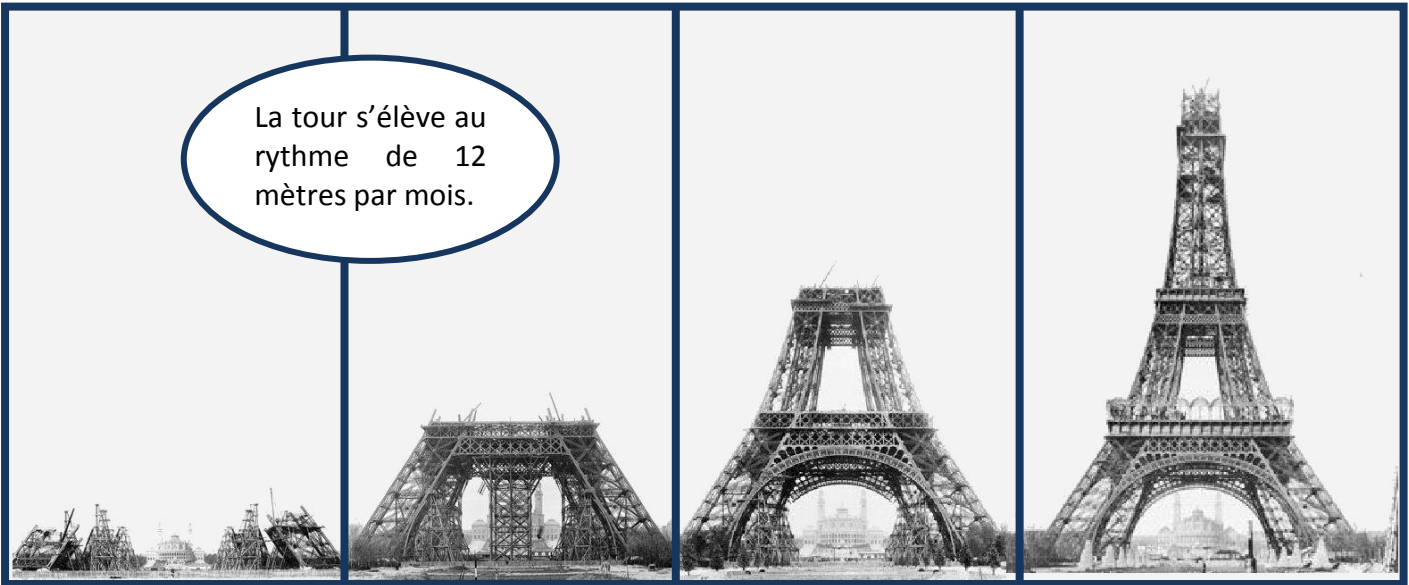
Des étapes de construction de la tour Eiffel (entre 1888 et 1889)
