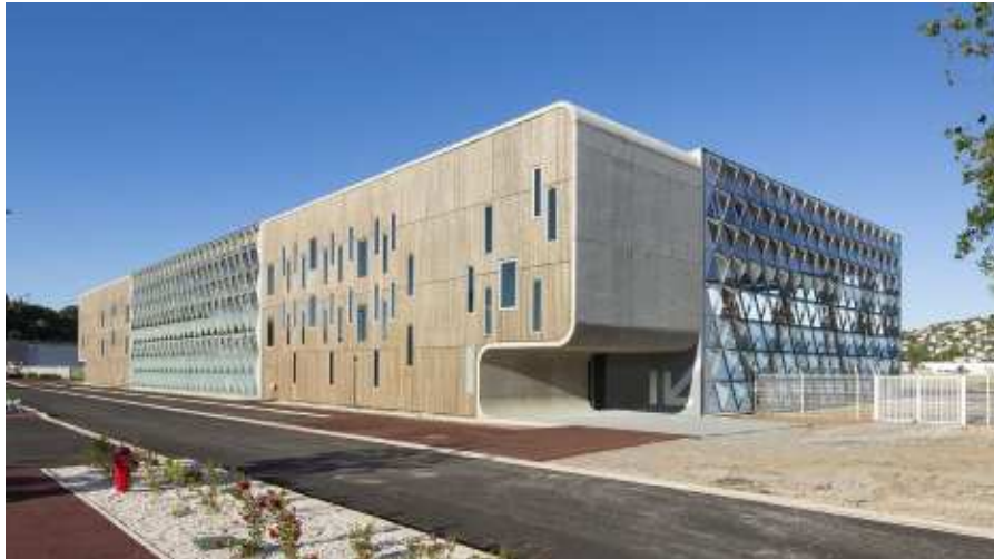
Nouveau bâtiment signal le long de la RD955
