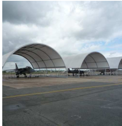
Parcours extérieurs autour du bâtiment
