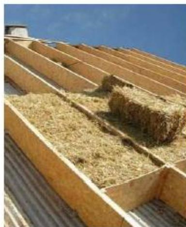
Il disposera les bottes de paille sur la surface correspondant à la zone grisée, pour créer une isolation de  $35 \text{ cm}$  d'épaisseur.
