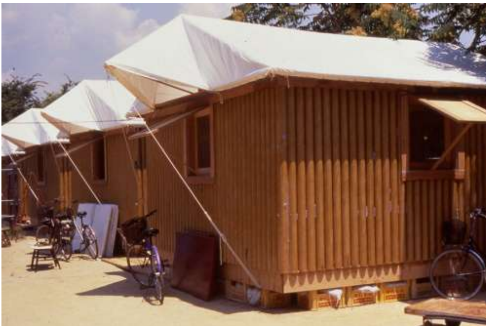
Les abris pour les survivants du tremblement de terre de Kobe, Maison en rondins de papier , 1995, par l'architecte Shigeru Ban, photo : Shigeru Ba
