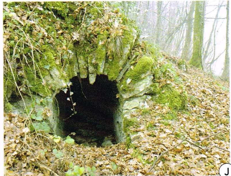
Aqueduc : conduit maçonné et voûté amenant l'eau à Vesontio (1 er - 2 e siècles).
