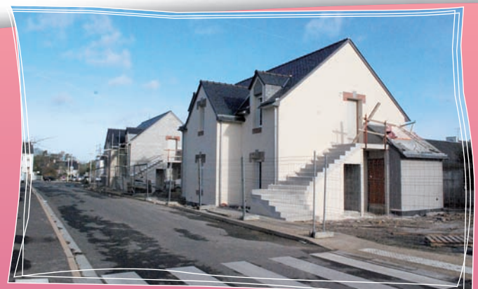
■ Quatre appartements en construction avenue de l'Océan.
