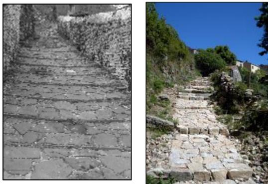
Ces travaux de préparation sont réalisés par par sections d'ouvrage afin de faciliter l'avancée du travail de pavage. Quand une section est terminée, les travaux de préparation reprennent sur la section suivante à empierrer.
