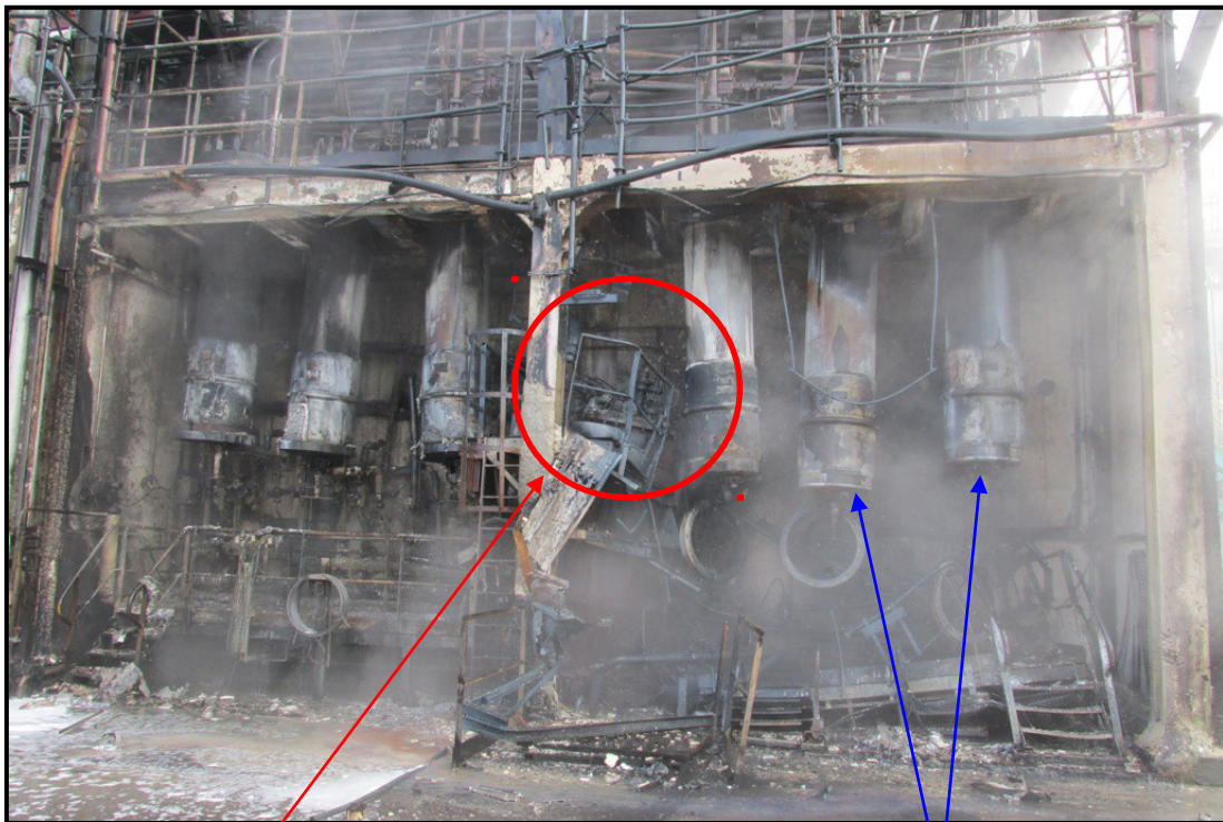
Photo 1 : zone de récupération des graisses
