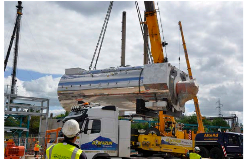
Chaudière vapeur RC4
