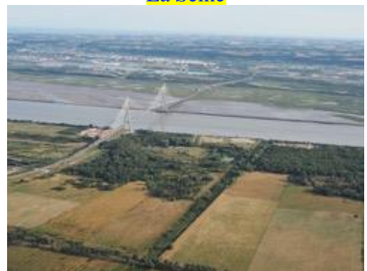
Pont de Normandie
