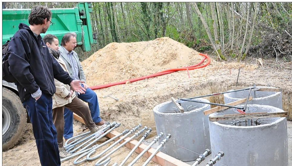
Jean Rinaldi et Bénédicte Michel ont interrompu le chantier d'installation du pylône. Photo M.A.
