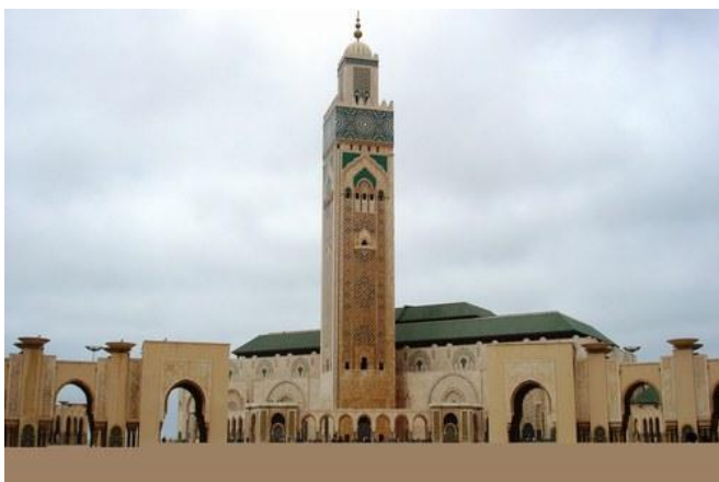
Mosquée de Casa (Maroc)
