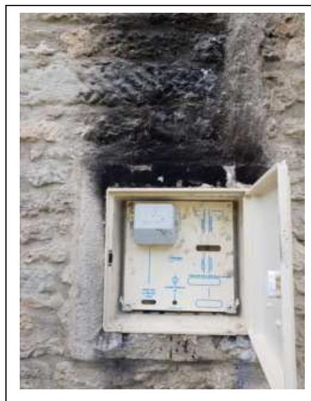
**2 – Coffret et platine support changés. compteur non réinstallé.**
