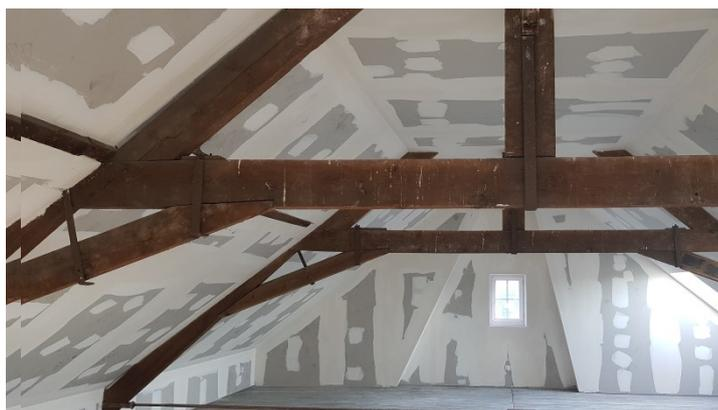
Les tuiles vieillissantes de la toiture de la mairie ont été remplacées . Afin de réaliser des économies d'énergie, des travaux d'isolation ont été réalisés avec laine de roche et plaques de plâtre. Trois velux ont été installés.
