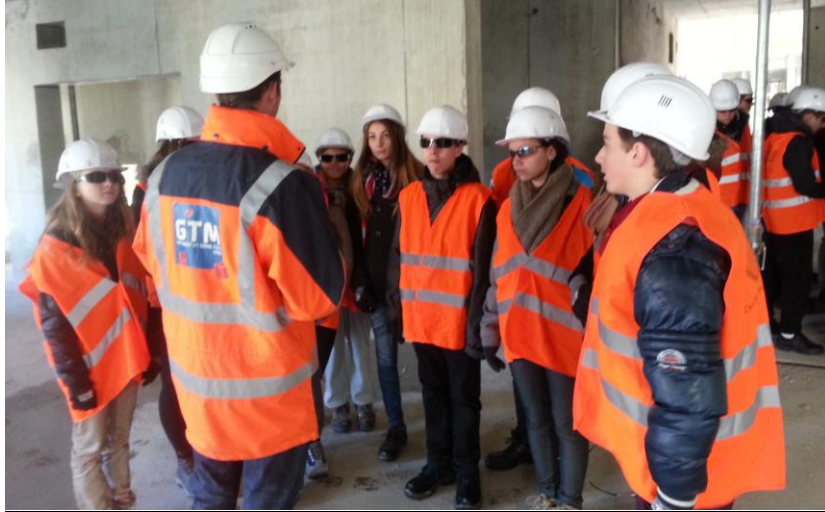
Visite du chantier du nouvel hôpital de Chambéry
