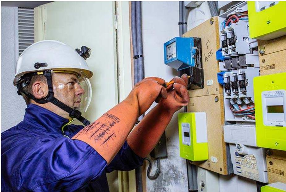
Ce dispositif est un compteur dit « communicant », c'est-à-dire qu'il peut recevoir des ordres et envoyer des données grâce à un pilotage à distance. Plus besoin donc d'attendre le technicien pour relever les consommations ou faire modifier la puissance du compteur ! Fini également le temps des estimations : Linky transmet automatiquement vos consommations réelles à votre fournisseur d'énergie qui vous facture en conséquence.
