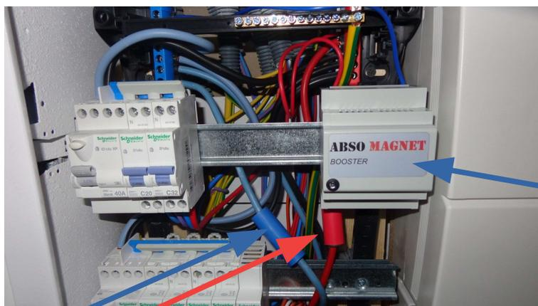
Boîtier dans lequel se trouve les condensateurs de filtrage : ce boîtier est branché en parallèle entre phase et neutre
