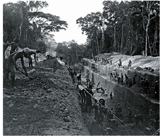
Construction d'une voie ferrée en Côte d'Ivoire, AOF, vers 1907
