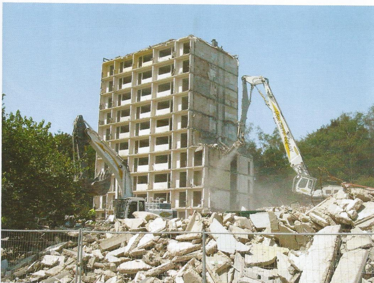
Doc. 6 Démolition d'un immeuble à Quimper, dans le Finistère (Bretagne).
