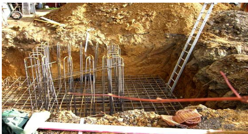
Fondation et ferrailage de la semelle béton du support du pylône des antennes camouflées de Bouygues Telecom (Tassin la Demi-Lune).
