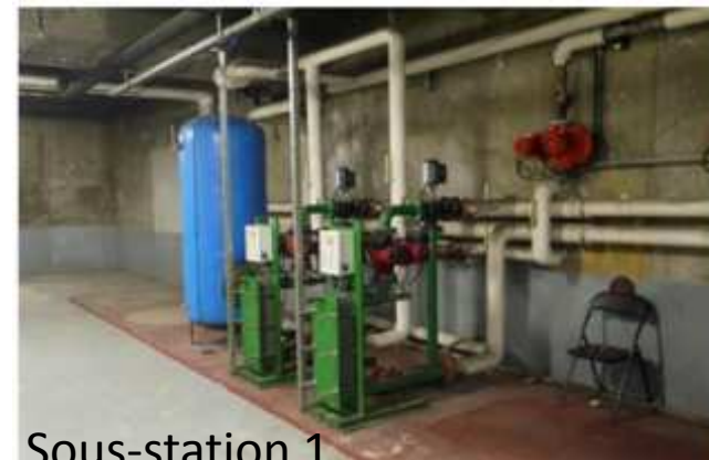
Sous-station principale et ses 6 échangeurs à changer.
