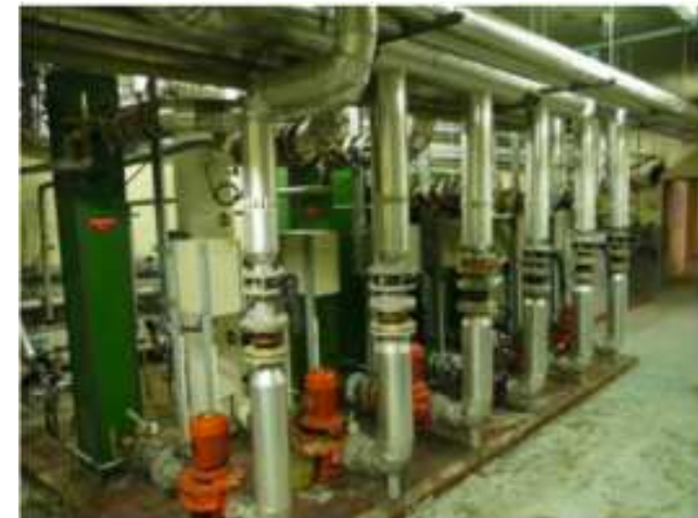
Sous-station principale et ses 6 échangeurs à changer.
