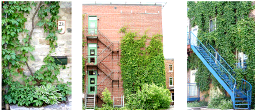
Murs végétaux simples de façade
