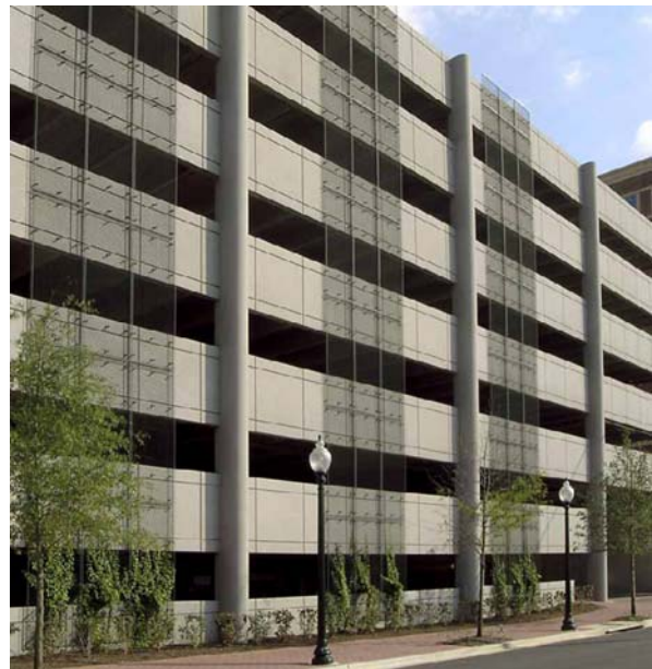
Lierre poussant à partir du sol sur une structure métallique
