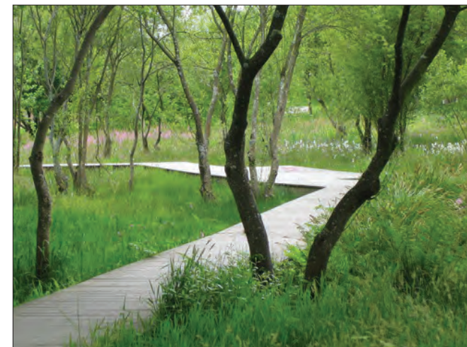
Un platelage bois pour traverser la zone humide
