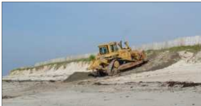
Photo 8: Travaux de réengraissement des dunes du Ster en Penmarc'h - M.Diascorn 08
