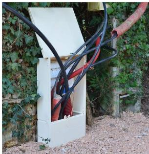
Une opération de renforcement consiste à adapter le réseau public d'électricité au développement des besoins des usagers. L'objectif est de résorber les chutes de tension afin d'améliorer la qualité de la fourniture.
