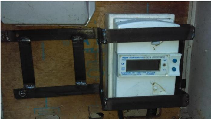
**5/ Protection mise en place. Espace vide à gauche du compteur, protégé, pour éviter la pose du Linky à côté.**
