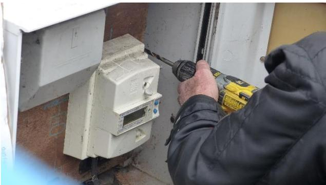
**3/ Perçage des 4 trous où viendront se loger les 4 tiges filetées.**
