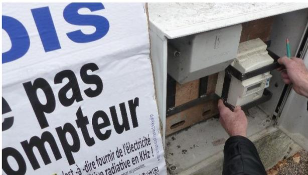
**2/ Vérification de la bonne prise de cote et traçage des points à percer aux 4 extrémités (attention vérifier l'absence de fils électriques)**
