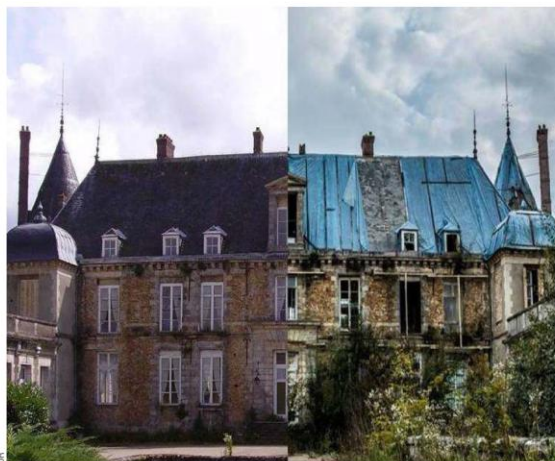
Fontenay-Trésigny (Seine-et-Marne). Visuel de ce qui devrait devenir le château du duc d'Épernon, aujourd'hui à l'abandon (à droite) après sa restauration (à gauche).
