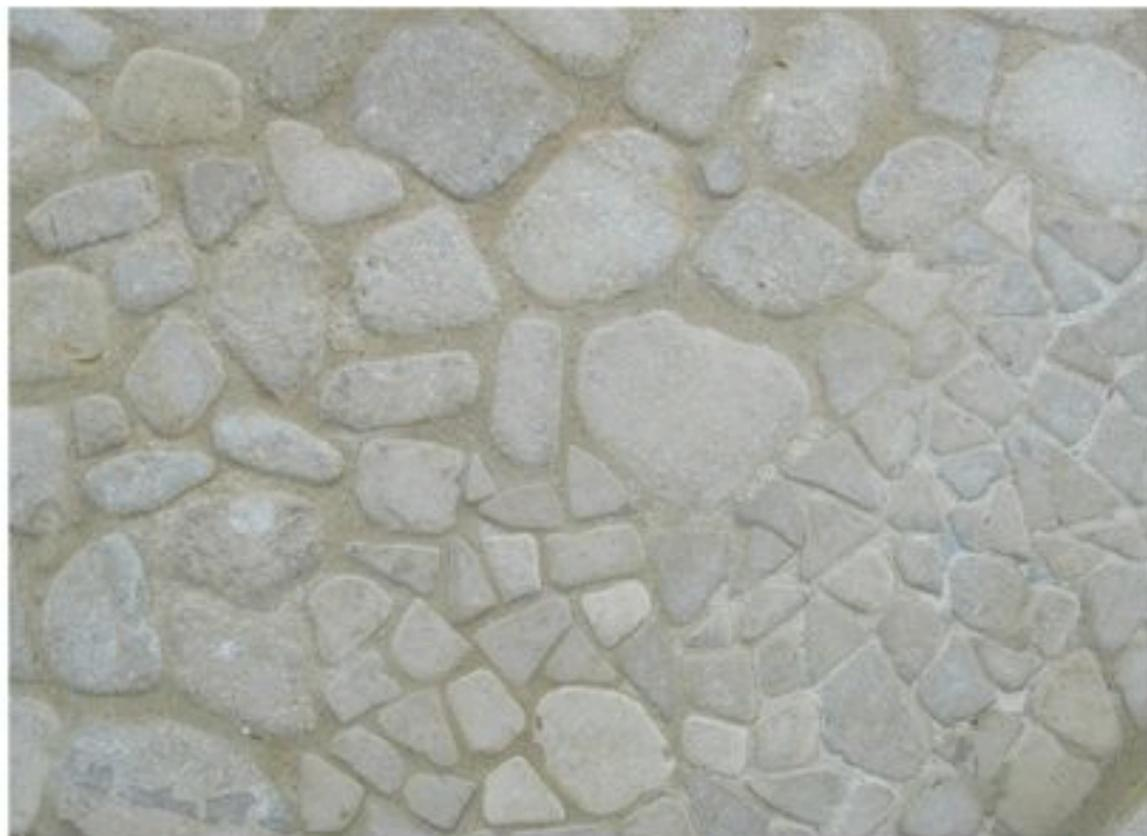
Une norme (DIN 13318) prescrit pour les pavés en béton une largeur de joint de 3 à 5 mm.
