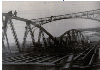
pont en construction.
