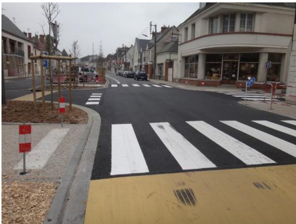
Carrefour boulevard Jeanne d'Arc-rue des Écoles, vu depuis le boulevard - Cliquer sur la photo pour l'agrandir
