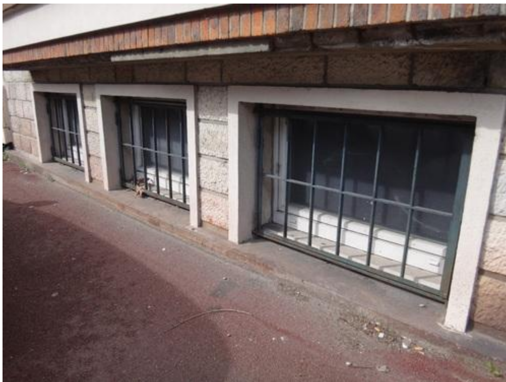
Rue du Faubourg Saint-Germain (un sous-sol assurément bien éclairé)
