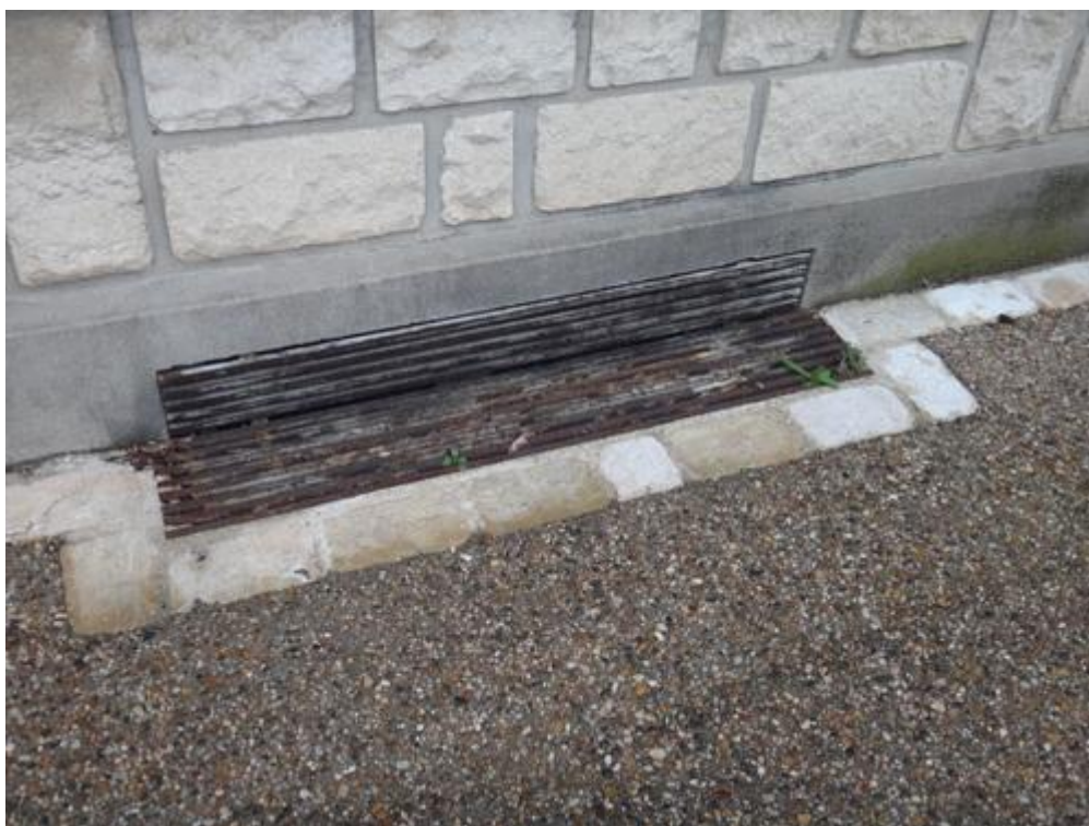
Rue Foch (Cas rare où la fenêtre empiète sur le trottoir)
