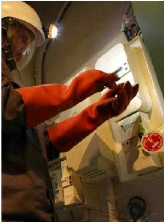
Les premiers compteurs Linky ont été posés dès janvier 2015. Aujourd'hui, Enedis vient de passer le cap des cinq millions de boîtiers installés. PHOTO MARIE DESHAIVES/SUD OUEST
