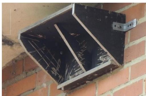
**Support de nidification** en triplex marin installé pour l'hirondelle de fenêtre. Pour une bonne adhérence de la terre au support, un rainurage est nécessaire ou la pose d'un morceau de toile moustiquaire.
