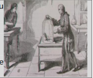
Dispositif de Lavoisier. L'expérience est terminée quand le niveau du mercure ne monte plus sous la cloche.
