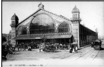
Photo de la gare du Havre
