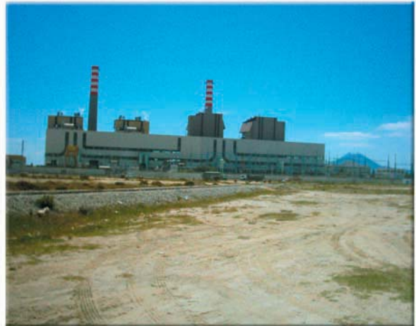
محطة توليد الطاقة الكهربائية برادس-تونس
