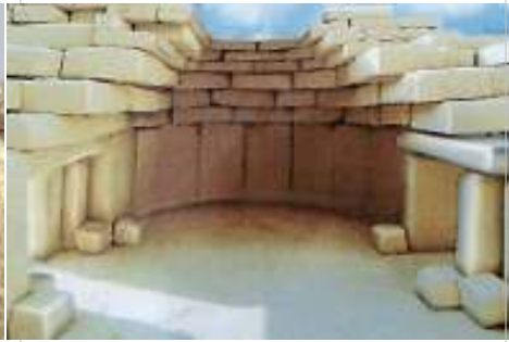
Tentative de restitution de la technique de construction des couvertures lithiques des temples maltais
