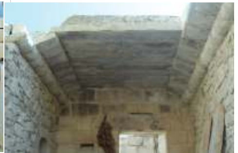
Couverture terrasse traditionnelle d'une ferme maltaise du XIX e siècle, très similaire à la couverture supposée des temples
