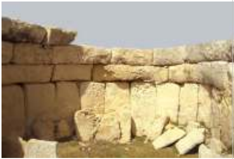
Fond d'une abside montrant les lits de pierres en encorbellement Temple de Haġar Qim
