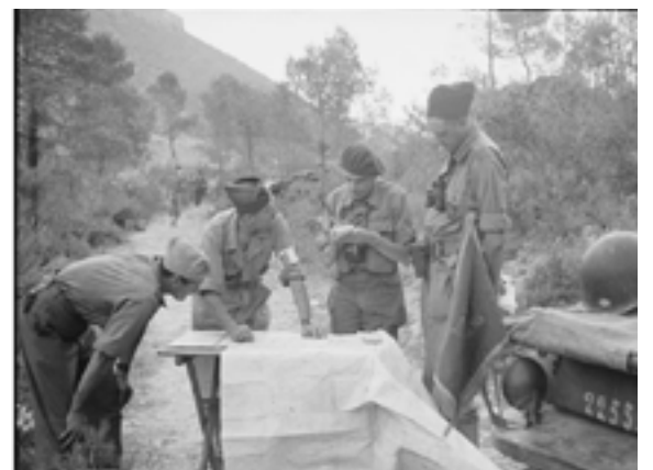
Poste de commandement opérationnel français en phase de déploiement autour de la ville de Toulon
