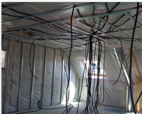
Installation d'un circuit électrique dans une maison
