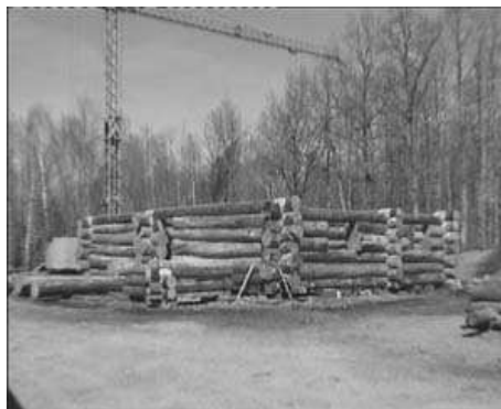
(1) Positionnement des troncs à la grue
