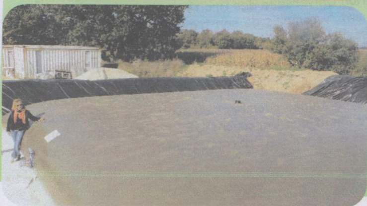
Bas : original, une réserve d'eau de 120 m3 exigée par la commission de sécurité...
