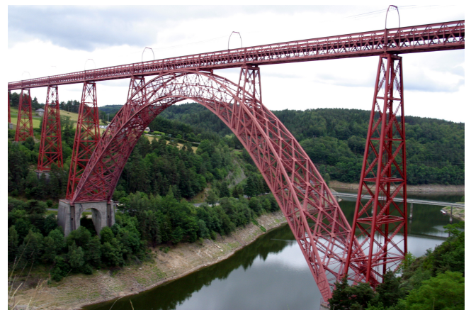
Viaduc de Garabit
