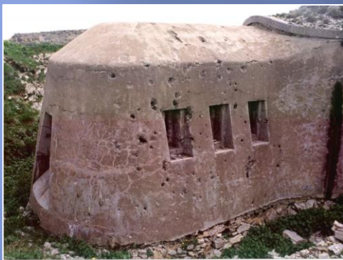
Détail des deux caponnières du fort des Mille-Fourches Source : Pascal Diana
