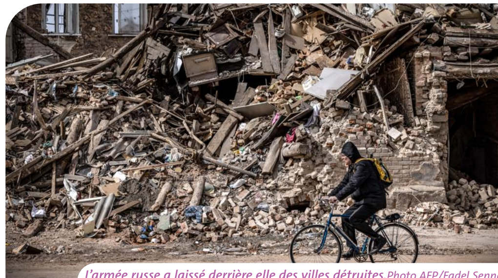
L'armée russe a laissé derrière elle des villes détruites. Photo AFP/Fadel Senna
