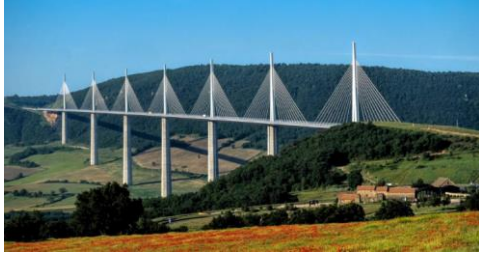
K Viaduc de Millau (Occitanie)
