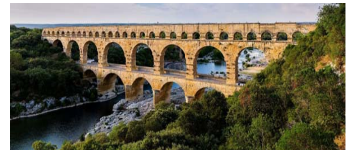
Le Pont du Gard qui permet à l'aqueduc d'acheminer l'eau jusqu'à la ville de Nîmes (I er siècle)
