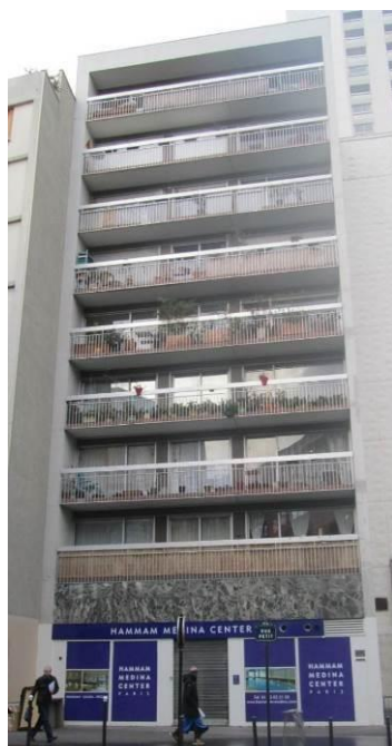
Façade Sud rue Petit
