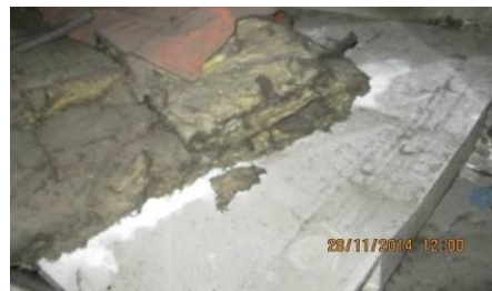
Panneau démonté (remplacé après la tempête de 1999)
