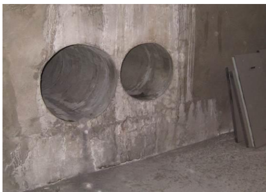
Gaines d'extraction pénétrant dans Le local extracteur
