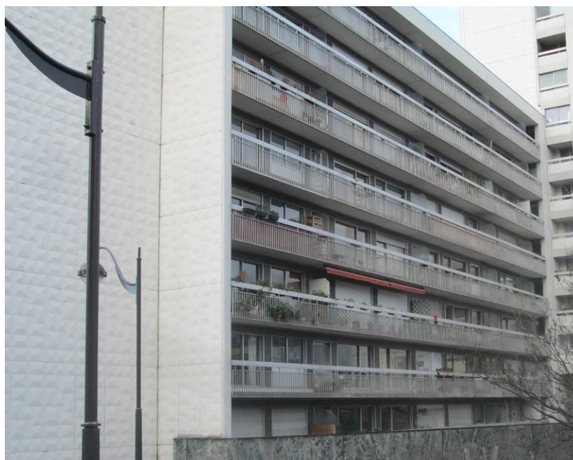
Façade Est rue Danjon
