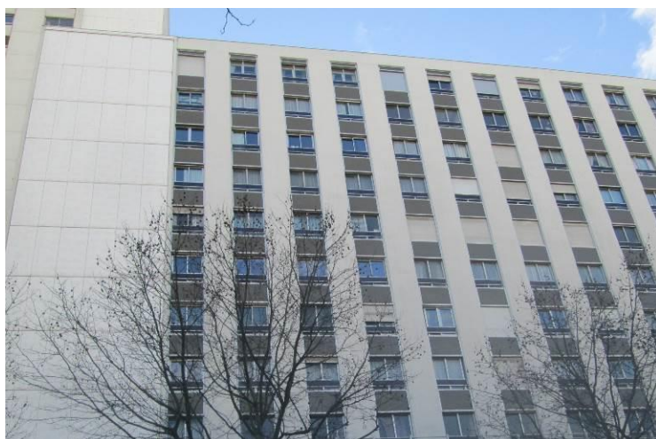
Façade Nord Avenue Jean Jaurès
