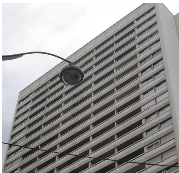
Façade Est sur rue Danjon
