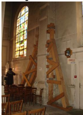
Etayage du pilier Sud 1998
