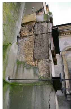
Pilier Nord Ouest
