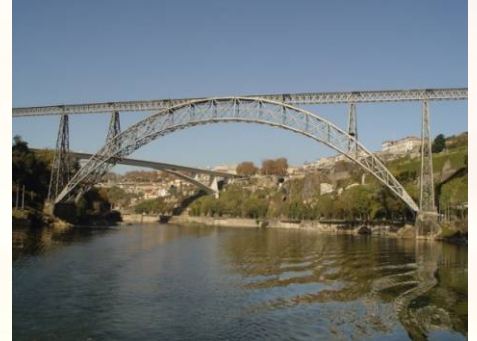
Le viaduc Maria Pia (Portugal).
